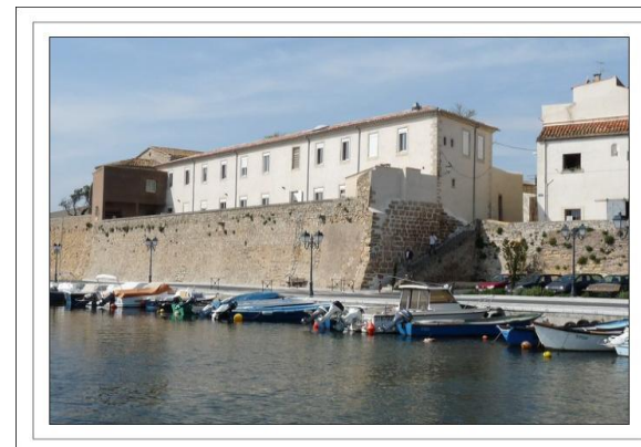
Lieu : Maison des Pénitents à Mèze, rue Villaret-Joyeuse
